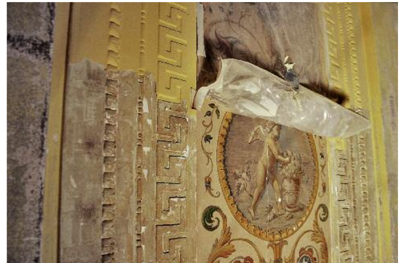
02 Freilegung der bauzeitlichen Wandmalerei
