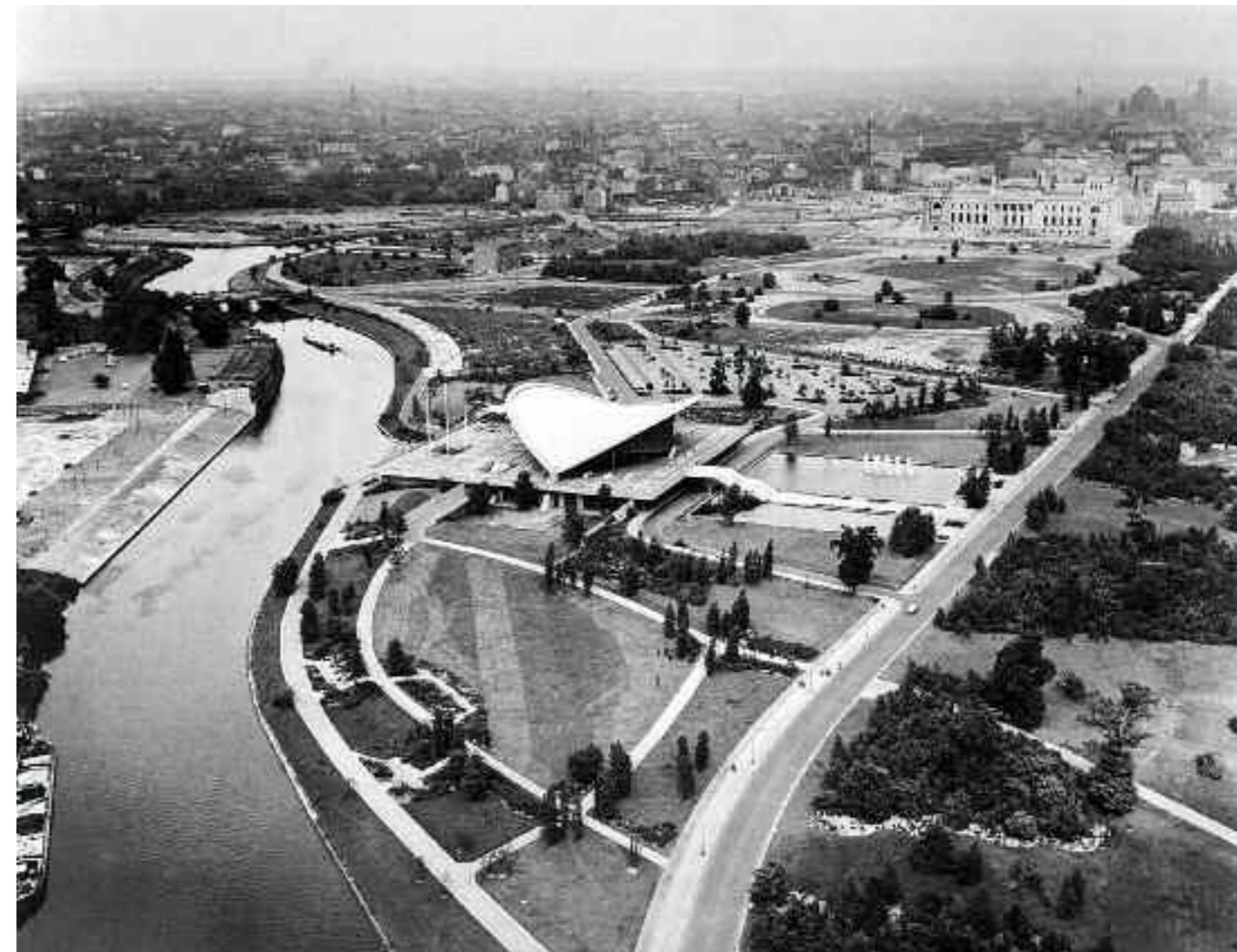
Luftbildaufnahme der direkt an der Spree gelegenen Kongresshalle, 1958
