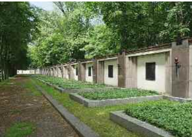
An der Umfassungsmauer reihen sich insgesamt 43 Grabnischen aneinander, 2017
