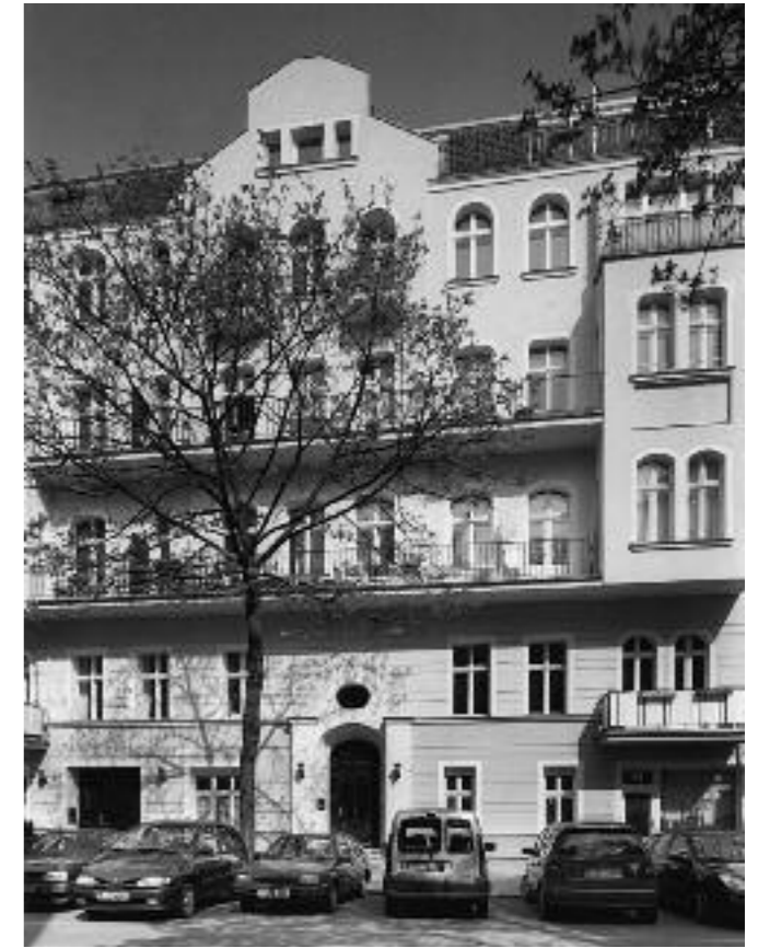
60. Willmannsdamm 6, Eingangportal, Vestibül und Treppenhaus des Mietshauses, 1894 von Joseph Bering
