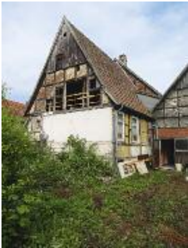
Abb. 11: Das nach einem Ortsbrand 1796 neu errichtete Gasthaus Hoetmarer Straße 11 in Freckenhorst, Gartenansicht
