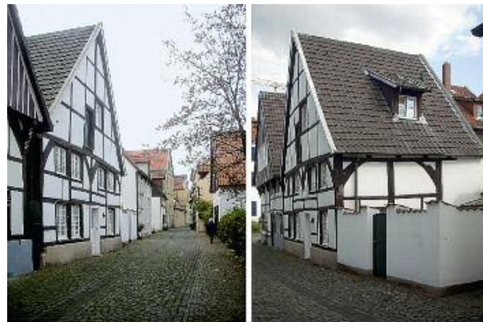
Abb. 13: Das Haus Gerichtsfuhlke 3 dürfte ebenfalls um 1615 als Doppelgadem errichtet worden sein. Ansicht von Osten und Westen (Zustand 2012).
