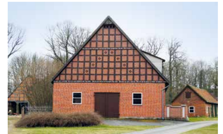
Abb. 1: Massivuntermauerung aus der Zeit vor der Denkmalschutzgesetzgebung, Beispiel aus Gühlitz (Foto: Kerstin Duncker).
