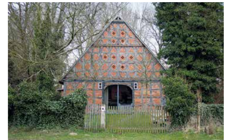
Abb. 2: Überformung eines niederdeutschen Hallenhauses aus der Zeit nach der Denkmalschutzgesetzgebung, Beispiel aus Mammoiße, Umnutzung mit reiner Wohnnutzung, Verglasung der Grot Dör (Foto: Kerstin Duncker).
