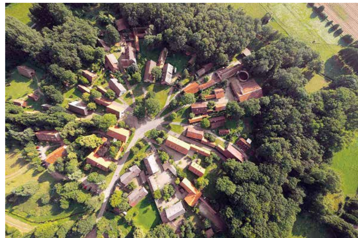
Abb. 1: Luftbild des Rundlingsdorfes Lübeln. Foto: Alexander Tetsch, April 2014, Samtgemeinde Lüchow (Wendland).
